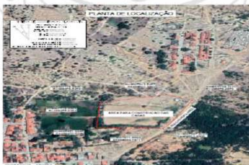
Imagem 1: Local para Construção de Casas Populares, Chorrochó-BA.
